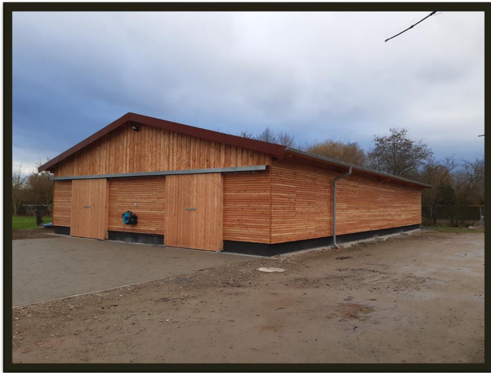
Eingangsseite (Ost) sowie Längsseite (Nord)
