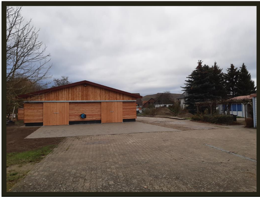
Vor der Bootshalle ist Drainagepflaster verlegt worden und der Anschluss an den vorhandenen Waschplatz wurde hergestellt
